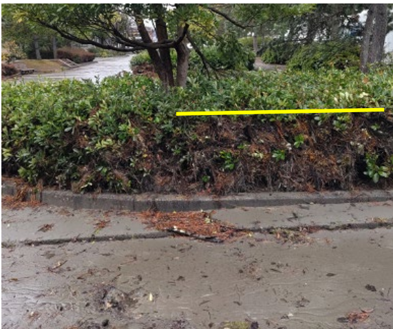
写真 8 - 15 : 津波の痕跡 (珠洲市見附公園)
